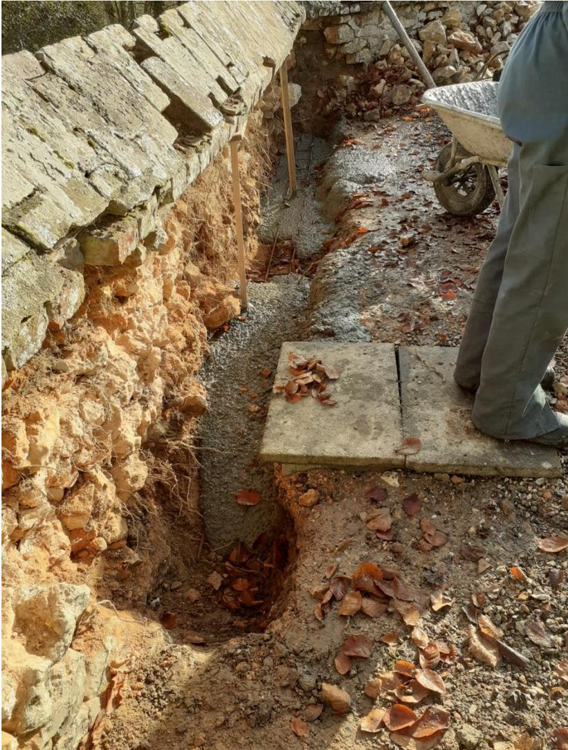
Le démontage étant réalisé, il a été creusé une tranchée à la base du mur, pour y couler du béton
