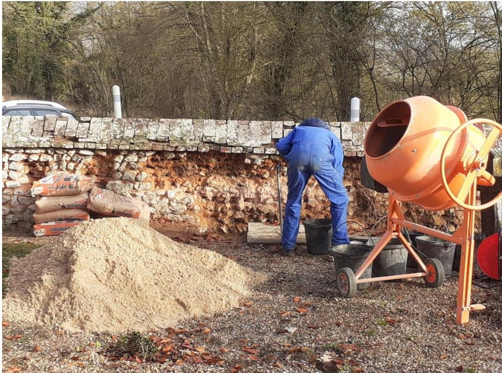
Les pierres sont démontées une à une, mais sur une DEMIE-EPAISSEUR, afin de garder les alignements et la hauteur du mur initial.
